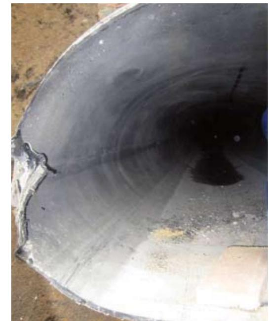
Cause du renouvellement: Le tube fortement déformé DN600.
