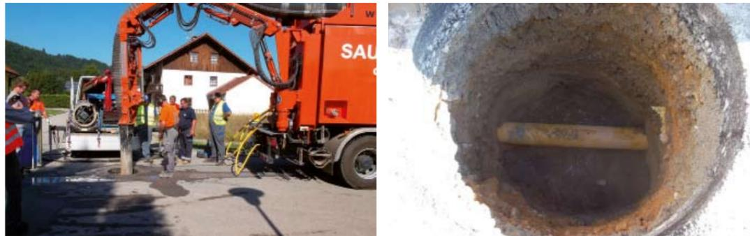
Image de gauche en haut: Réalisation d'un Keyhole avec un foret-couronne. Aux second plan, la maison à connecter à la canalisation de gaz. Image de haut à droite: Prélèvement de la galette. Image du milieu à gauche: Travail du camion aspirateur. Image du milieu à droite: Le Keyhole et la canalisation dégagés. Image de bas à gauche: GRUNDOPIT K opérationnel dans le Keyhole. Image de bas à droite: Ascenseur à tiges.
