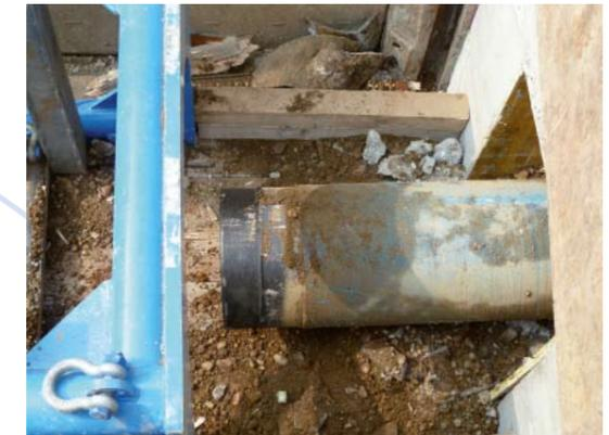
stallé dans la fouille de machine et raccordé à la centrale d'entraînement hydraulique. Ensuite, les tiges d'éclatement sont aiguillées dotées du mandrin de guidage, qui plus tard sera remplacé par la tête d'éclatement et d'alésage et le nouveau tube à entraîner. Lors du mouvement de retour, la tête à molettes éclate l'ancienne conduite, l'aléreur
