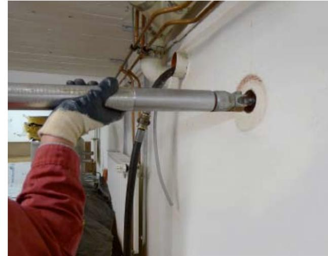
Ensuite, on a lancé la fusée GRUNDOMAT-N de Ø55 mm de fibre optique.
