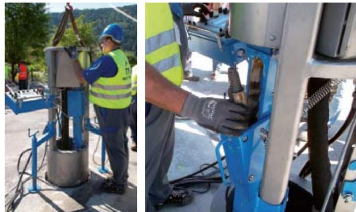
au niveau du mur de la maison est devenue caduque, la fusée pouvant être lancée depuis la cave de la maison. La taille de la fouille d'arrivée correspond approximativement à la longueur de la fusée, pour pouvoir la récupérer. Pour réduire la fouille à un minimum, l'intervenant dispose de fusées à longueur réduite.
