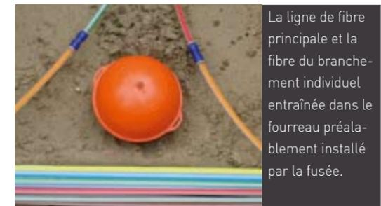
La ligne de fibre principale et la fibre du branchement individuel entraînée dans le fourreau préalablement installé par la fusée.
