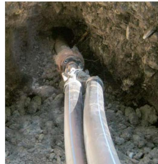
Entraînement de deux tubes PE-HD DA 63 en faisceau.
