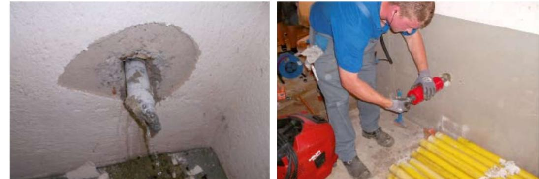
Image de gauche en haut: Arrivée de la tête de forage dans le local technique de la cave. • Image de haut à droite: Changement d'outils: Tête de forage contre carotteur. • Image de bas à gauche: Entraînement du fourreau PEHD DA 63 mm. • Image de bas à droite: Branchement individuel installé (armature et raccord soudé).
