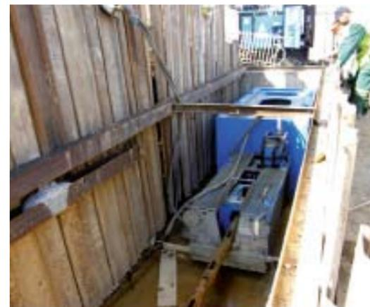
Le système GRUNDOBURST 2500 kN (force de traction de 250 t), une force qui permet de renouveler d'anciens tubes à partir de DN 300 jusqu'à  $\leq$  DN 1000.
