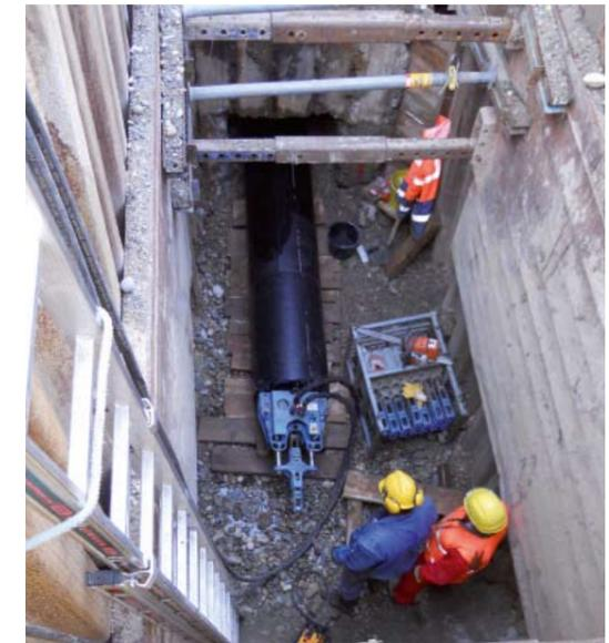
Le système Burstfix 400 a permis de serrer solidement les modules individuels de tube de 3m.
