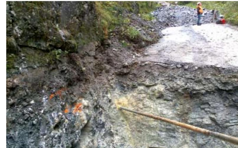
Forage guidé par câble avec une profondeur / recouvrement de 47m.
