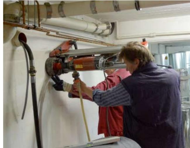
Après le nivellement et le repérage du point de forage dans la cave, on a réalisé le carottage de Ø 60mm à travers un mur d'agglos de 36 cm.
