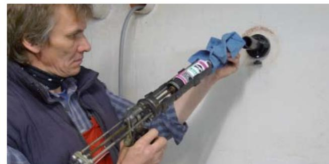
Pressurisation de la résine à deux composants dans le flexible. Le matériau s'étale dans les cavités et les zones d'éclatement du mur.
