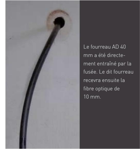
Le fourreau AD 40 mm a été directement entraîné par la fusée. Le dit fourreau recevra ensuite la fibre optique de 10 mm.
