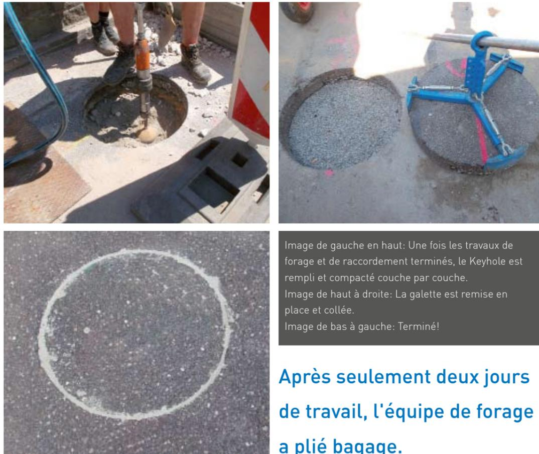
Image de gauche en haut: Une fois les travaux de forage et de raccordement terminés, le Keyhole est rempli et compacté couche par couche.
